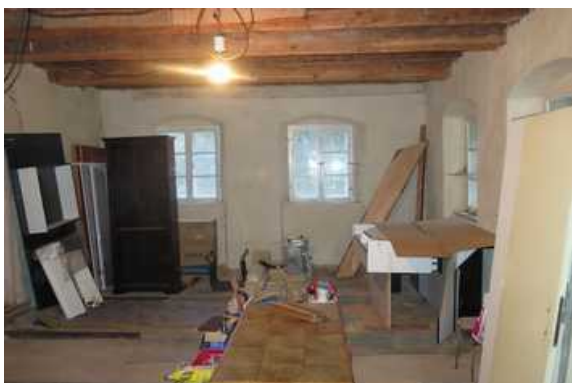
Pokoj v přízemí - stavebně neupraveno
