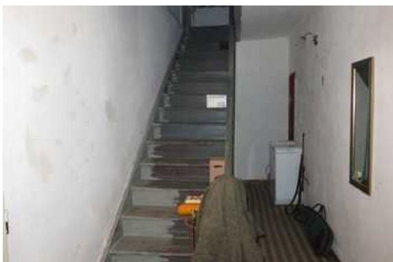
Chodba a schodiště v přízemí
